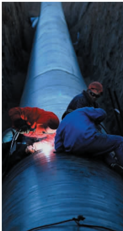
工人施工环境复杂,条件艰苦。
