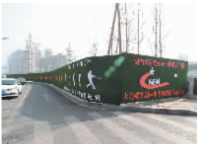
建设中的马栏河运动公园。
