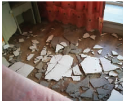
两平方米的墙皮脱落。
