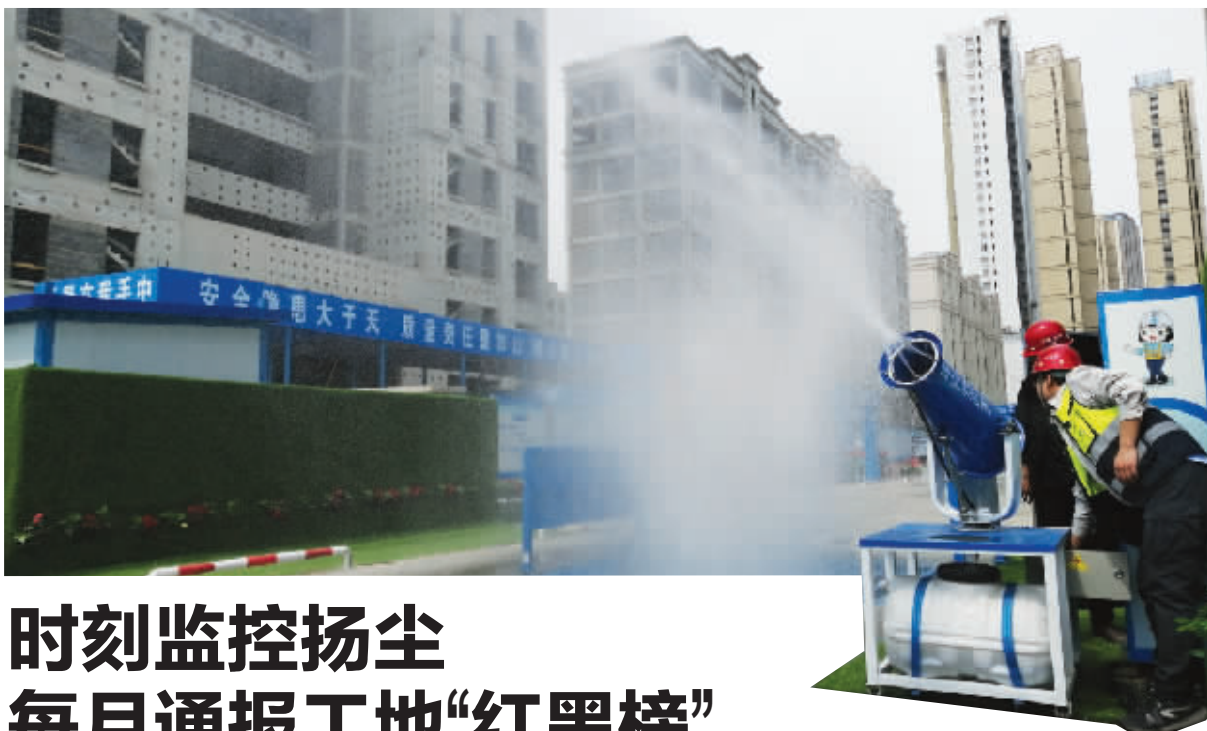
东港商务区内一处建筑工地在出入口设冲洗设施、雾炮。
