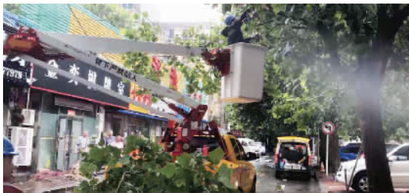
供电公司人员紧急抢修。
