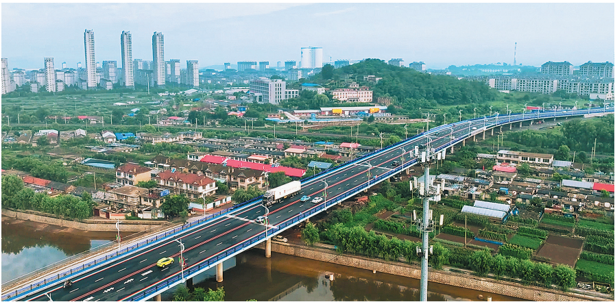
恢复通行后的普兰店区台山立交桥。
