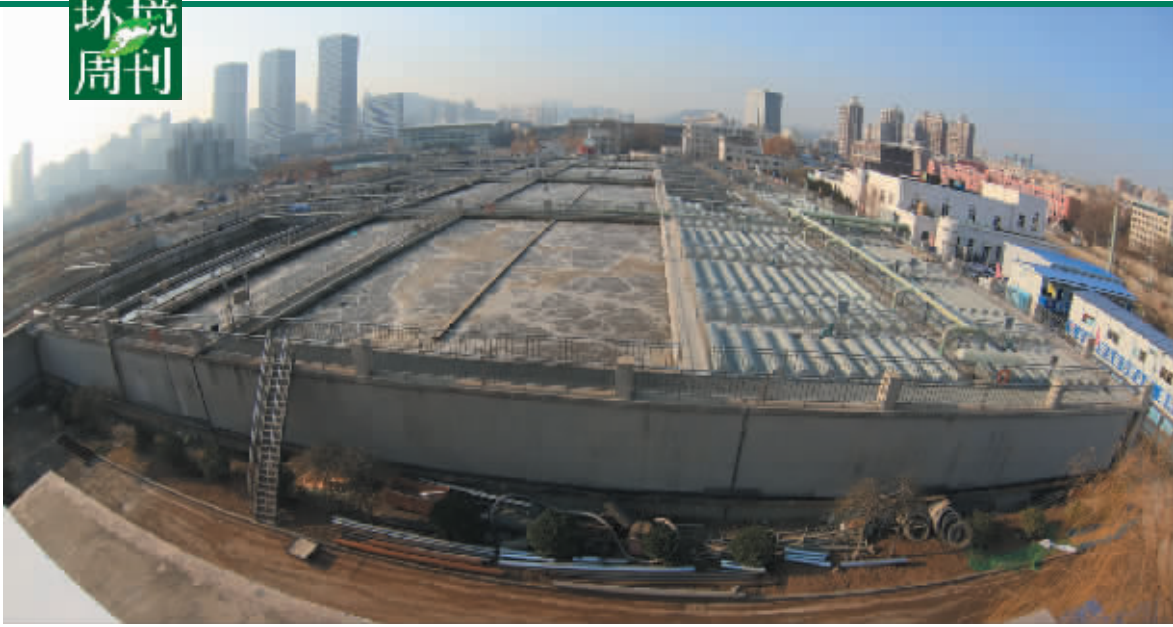
凌水河污水处理厂提标改造工程 12月3日通水运行。摄影记者张春雷
