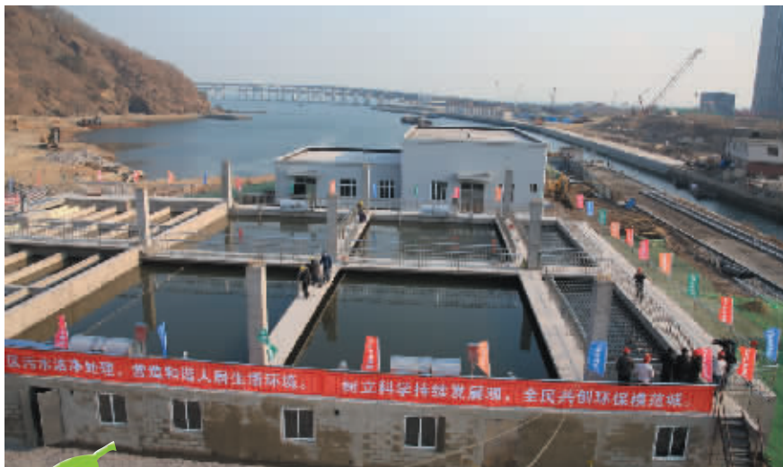
提标改造后的凌水河污水处理厂。摄影记者张春雷
